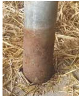
Korrosion ist in Ställen aufgrund von aggressiven Stoffen und der Umgebungsfaktoren weit verbreitet. Man sollte daran denken, diese abzubürsten und mit einer Bitumenfarbe zu streichen, sobald die ersten Spuren sichtbar werden.
