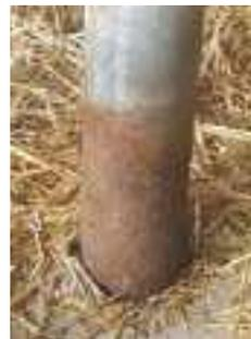
Korrosion ist in Stallanlagen aufgrund der aggressiven Stoffe und Umgebungsbedingungen weit verbreitet. Denken Sie daran, die entsprechenden Stellen zu bürsten und mit einer Bitumenfarbe zu streichen, sobald die ersten Spuren sichtbar werden.
