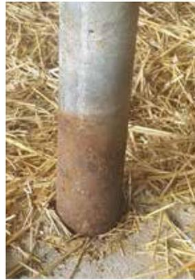
Korrosion ist in Stallanlagen aufgrund der aggressiven Stoffe und Umgebungsbedingungen weit verbreitet. Denken Sie daran, die entsprechenden Stellen zu bürsten und mit einer Bitumenfarbe zu streichen, sobald die ersten Spuren sichtbar werden.
